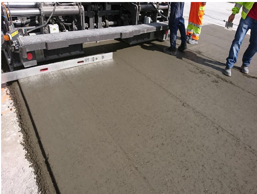
Rys. 3. Beton wykonywany w technologii bez wałowania. Tak ułożona mieszanka stanowi już warstwę finalną. Zdjęcie autora.
