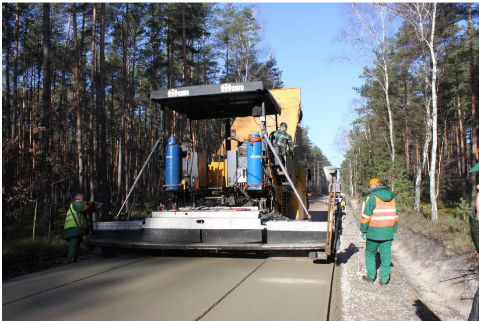
Rys. 2. Układanie betonu wałowanego. Zdjęcie autora.
