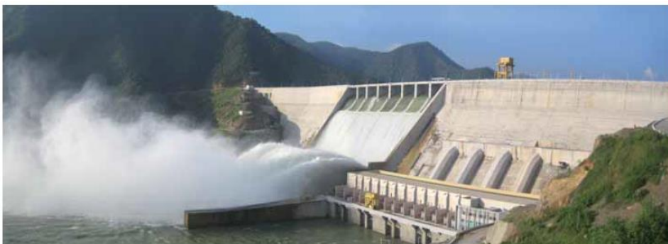
Rys. 13. Tama Yeywa na rzece Mytinge w Birmie wykonana w technologii betonu wałowanego wypełniona wodą po sezonie deszczowym [66].
