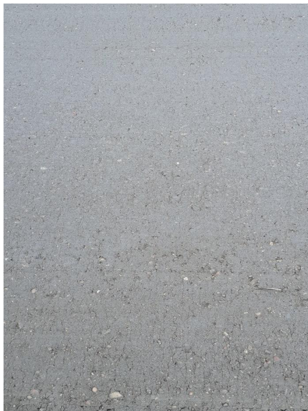
Rys. 46. Beton po stwardnieniu. Odpowiednia struktura, bez zjawiska „gniazd” kruszywa grubego oraz odpowiednio jednorodna, co widać na zdjęciu – m. in. Równomierny wygląd betonu bez zjawiska wyspowego przesychania. Budowa na terenie Cementowni Kujawy firmy HOLCIM. Zdjęcie autora.
