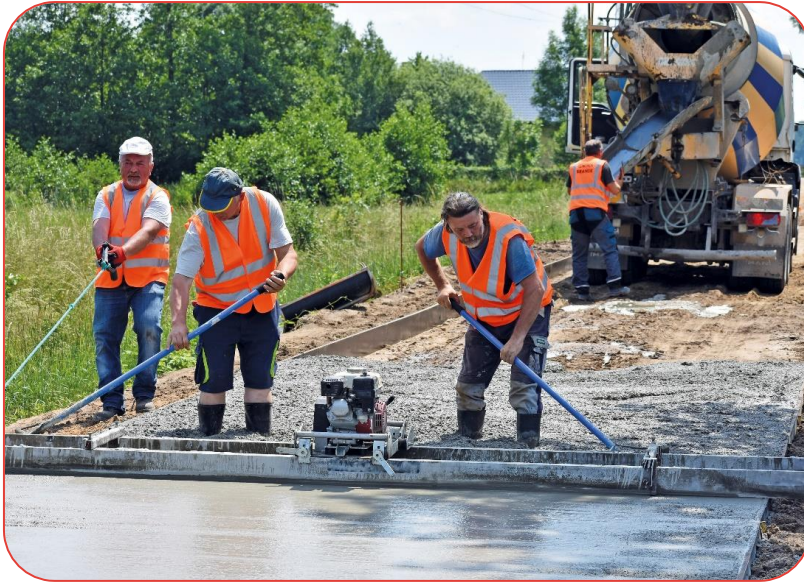
Rys. 1. Metoda układania betonu w deskowaniu stałym [3].
