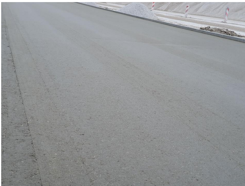
Rys. 48. Beton wałowany klasy C30/37Ł (załącznik 27) na kruszywie z Kopalni Łojewo. Dobór stosu okruschowego na podstawie punktu piaskowego. Budowa na terenie Kopalni Wapienno firmy HOLCIM. Zdjęcie autora.
