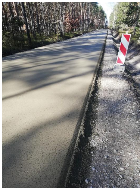
Rys. 12. Droga z betonu wałowanego na terenach leśnych. Zdjęcie autora.
