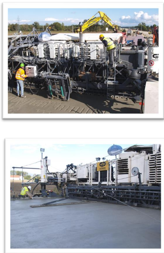
Rys. 4. Zestaw rozścielaczy do układania nawierzchni autostrad i dróg ekspresowych [11].
