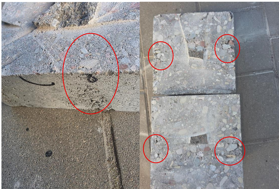
Rys. 66. Przekrój próbek z zaznaczeniem warstwy szczepnej i widocznych niedogęszczeń. Próbka zagęszczana metodą autorską. Zdjęcie autora.
