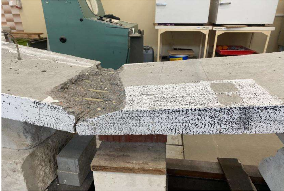
Rys. 51. Obraz zniszczenia – płyta K100-5.
