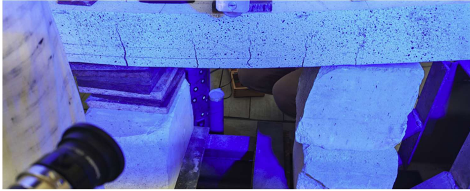
Rys. 53. Monitorowanie rys płyt GFRP.
