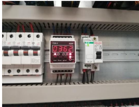
Rys. 21. Układ sterowania ruchomą przegrodą selekcyjną
