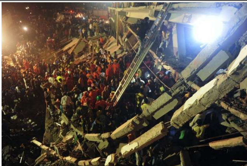
Fot. 3. Katastrofa budowlana w Bangladeszu. Przyczyną katastrofy były maszyny szwalnicze, wywołujące drgania konstrukcji [fot. AFP]
