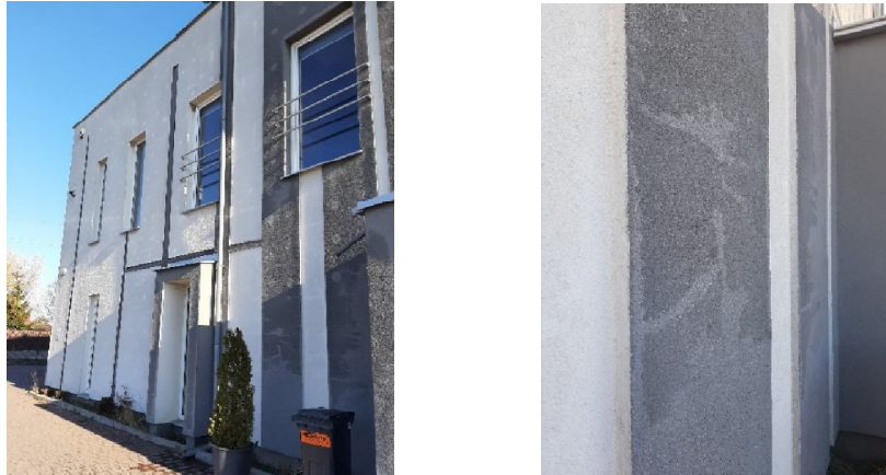
Rysunek 30. Kondensacja wilgoci na powierzchni elewacji – efekt promieniowania jasnego nieba (archiwum autora)
