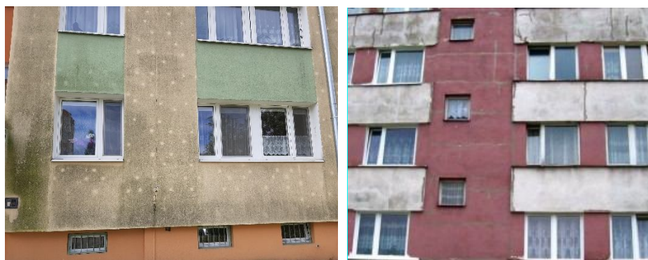
Rysunek 20. Korozja biologiczna o zróżnicowanej kolorystyce (archiwum autora)
