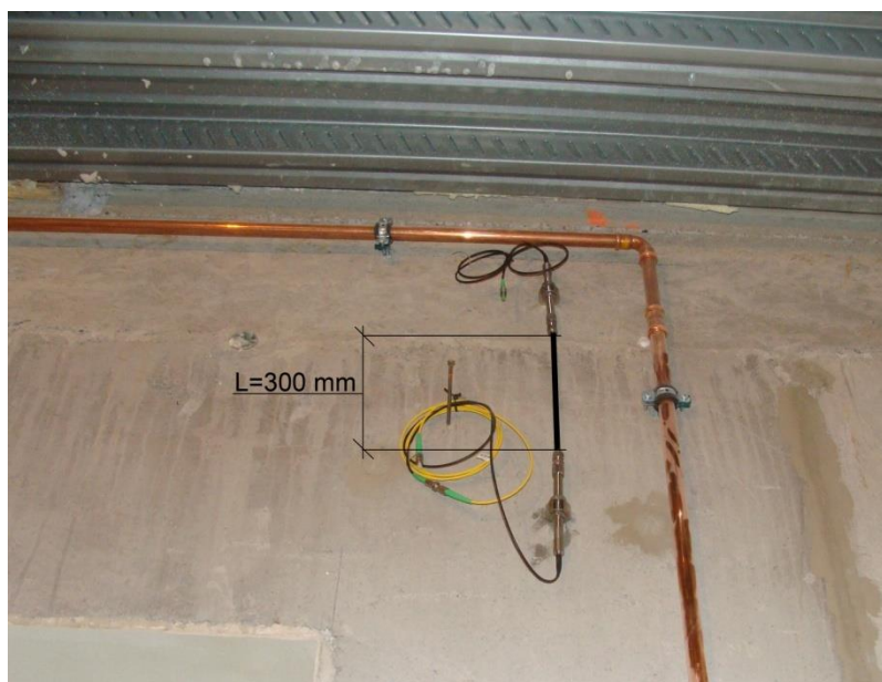
Fot. 7.15. Fragment badanej ściany w systemie „POLYTECH”
