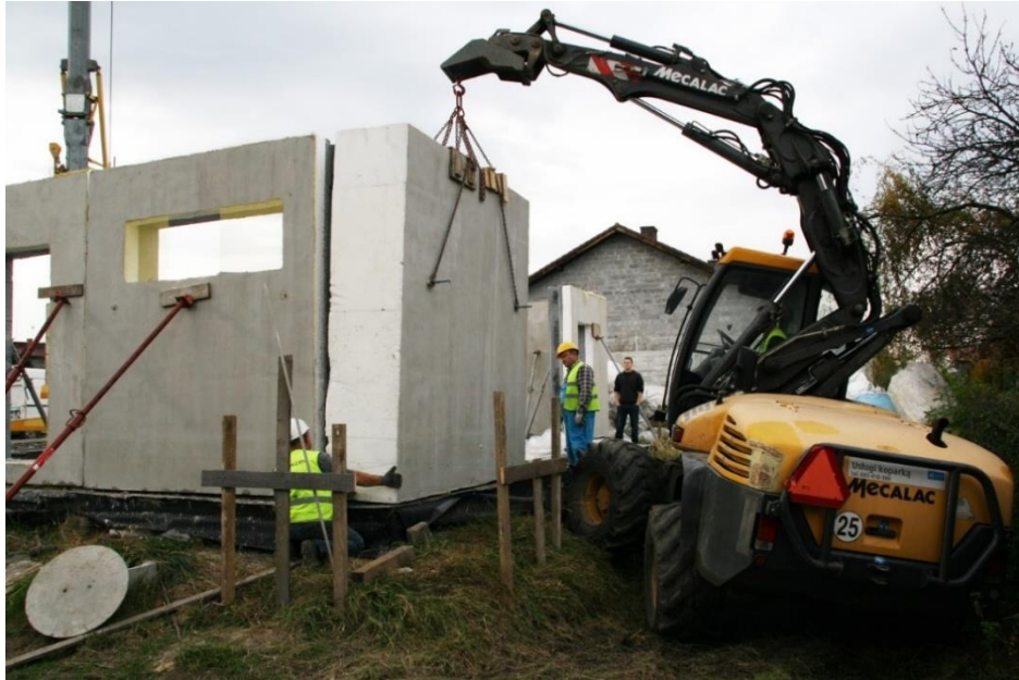
Fot. 6.3. Budowa domu modelowego z wykorzystaniem prefabrykatów, wykonanych z materiału „POLYTECH”
