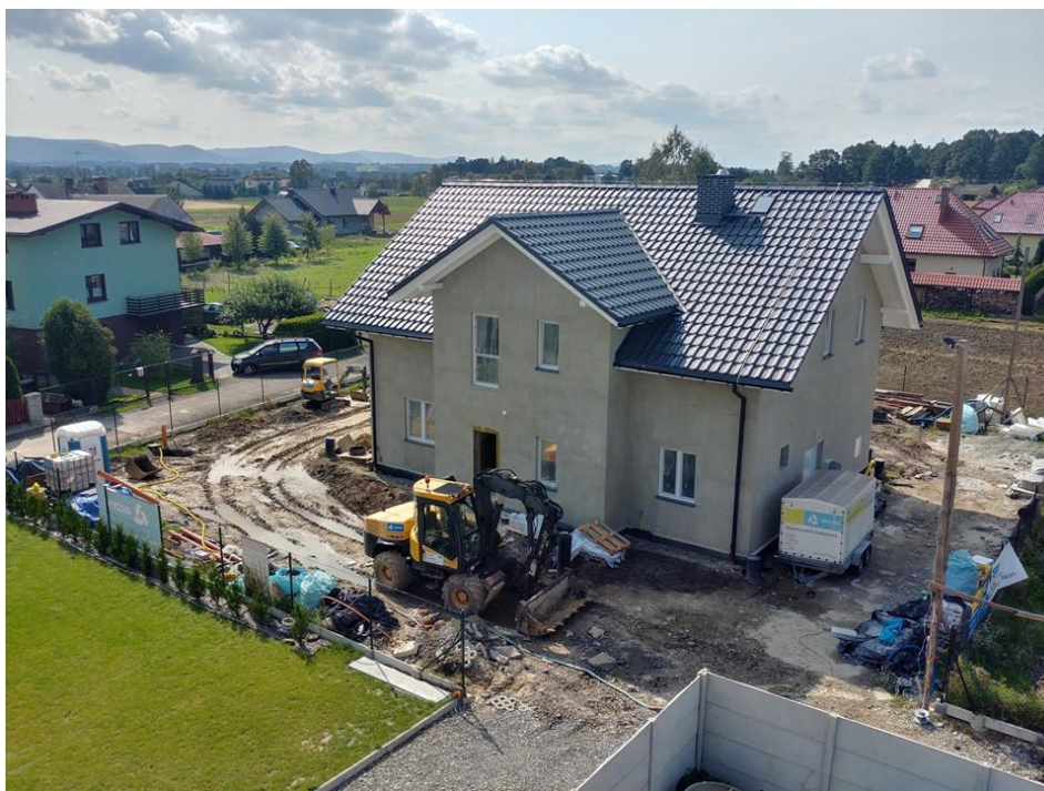
Fot. 6.5. Modelowy dom objęty badaniami – budynek mieszkalny jednorodzinny, wzniesiony z wykorzystaniem prefabrykatów, wykonanych z materiału „POLYTECH”
