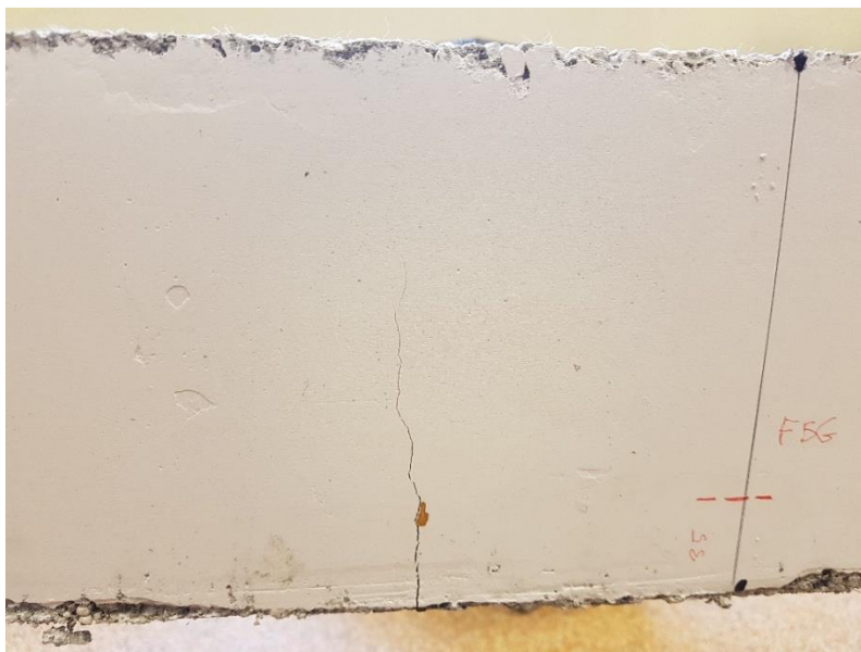
Fot. 7.3. Obiekt badań zniszczony w rezultacie przeprowadzonego testu nr 2, etap 4
