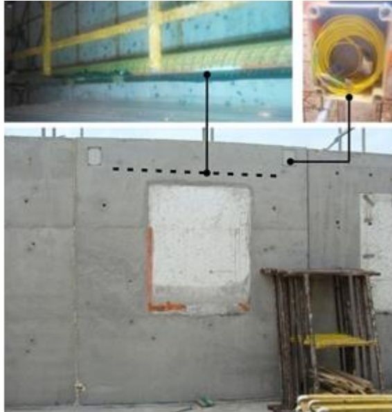
Fot. 7.8. Panel ścienny z nadprożem w systemie „POLYTECH” - lokalizacja czujników
