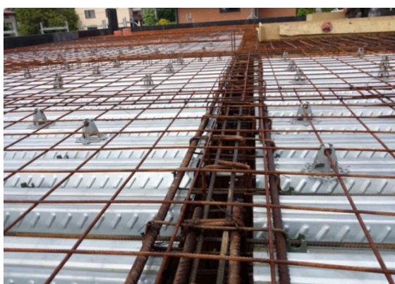
Fot. 7.12. Strop zespolony na etapie budowy
