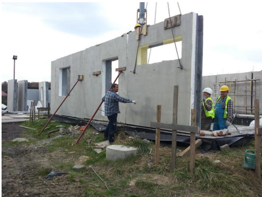
Rys. 6.1. Montaż paneli systemowych „POLYTECH”
