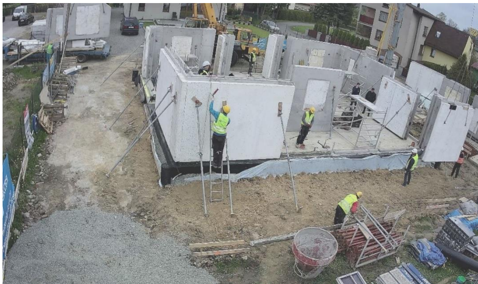
Fot. 6.4. Budowa domu modelowego z wykorzystaniem prefabrykatów, wykonanych z materiału „POLYTECH”
