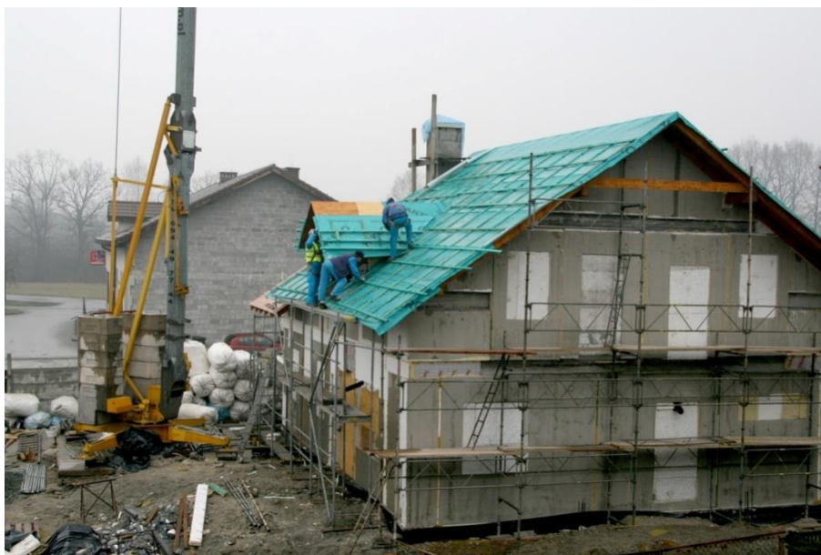
Fot. 6.2. Budynek zrealizowany w systemie „POLYTECH”
