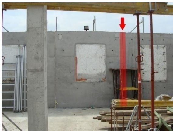
Fot. 7.10. Słup żelbetowy w systemie „POLYTECH” - lokalizacja
