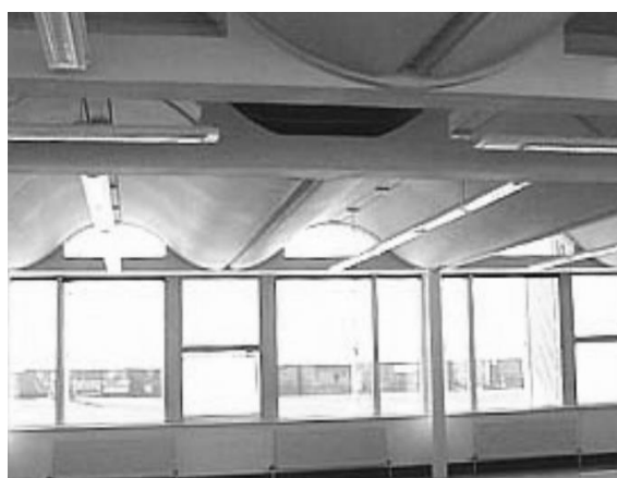
Rys.19. Zakrzywiony sufit w budynku biurowym w Garston (źródło: http://project.bre.co.uk )
