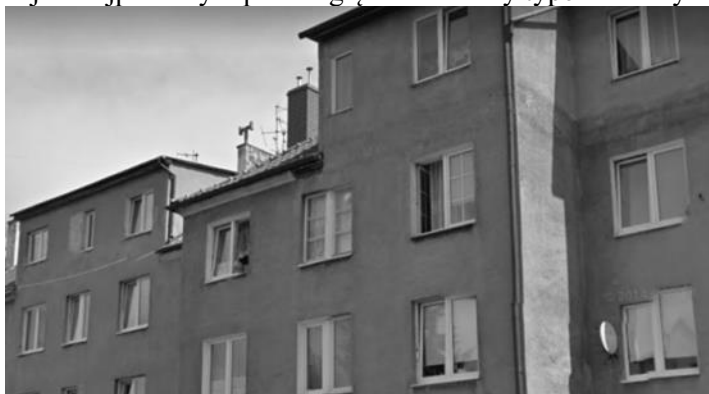
Rys.85. Nasada typu stałego. Budownictwo wielorodzinne Gdańsk, al. Legionów.
